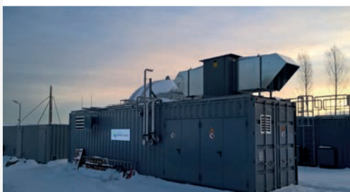
Biogaz: 100 Nm 3 /h Biométhane: 55 Nm 3 /h
